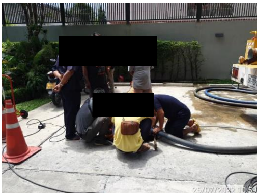
การสูบน้ำ และตะกอนระบบบำบัดน้ำเสีย (กิจกรรมการบำรุงรักษาระบบบำบัดน้ำเสีย)
