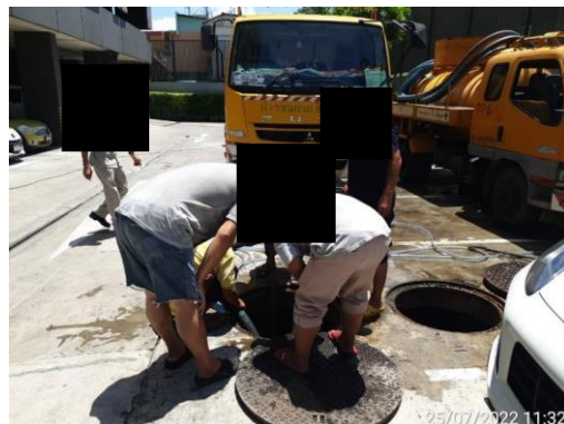
การสูบน้ำ และตะกอนระบบบำบัดน้ำเสีย (กิจกรรมการบำรุงรักษาระบบบำบัดน้ำเสีย)
